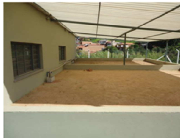
Figura 137. Local de secagem do lodo gerado na ETE do loteamento Terras de Monte Alegre
