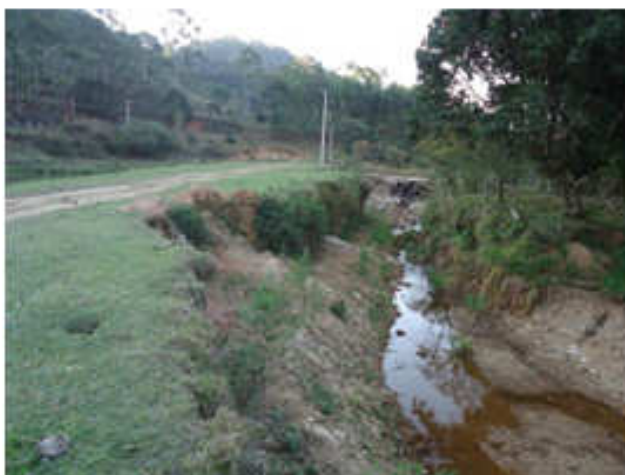
Figura 156. Erosão junto à margem do Córrego Monte Alegre em virtude da vazão do manancial
