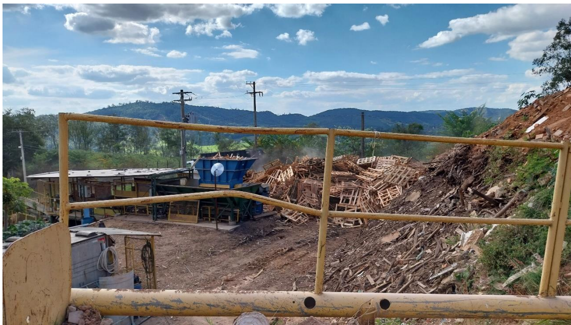
Foto 10 – Instalação privada processadora dos resíduos volumosos.
